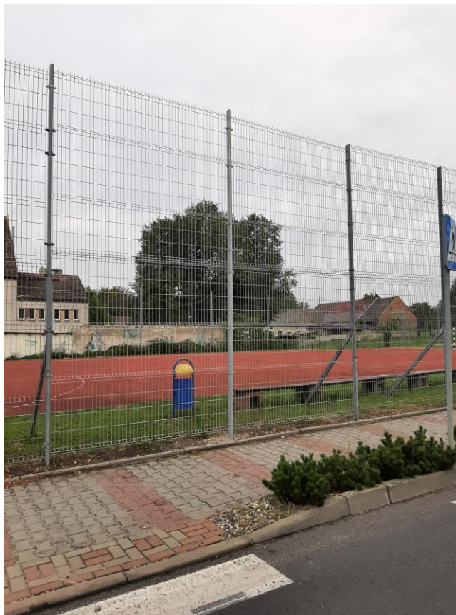
Zdj. 13 Naprawa uszkodzonego piłkochwyty przy boisku PSP nr 1 – po realizacji.
