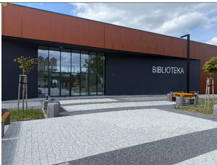
Zdj. 4 Budowa nowej siedziby biblioteki w Zdzieszowicach – zewnątrz biblioteki
