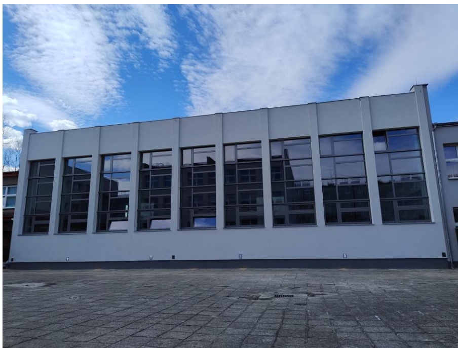
Zdj. 14 Termomodernizacja z częściową przebudową budynku szkolnego PSP nr 3 – segment F i D – po realizacji.
