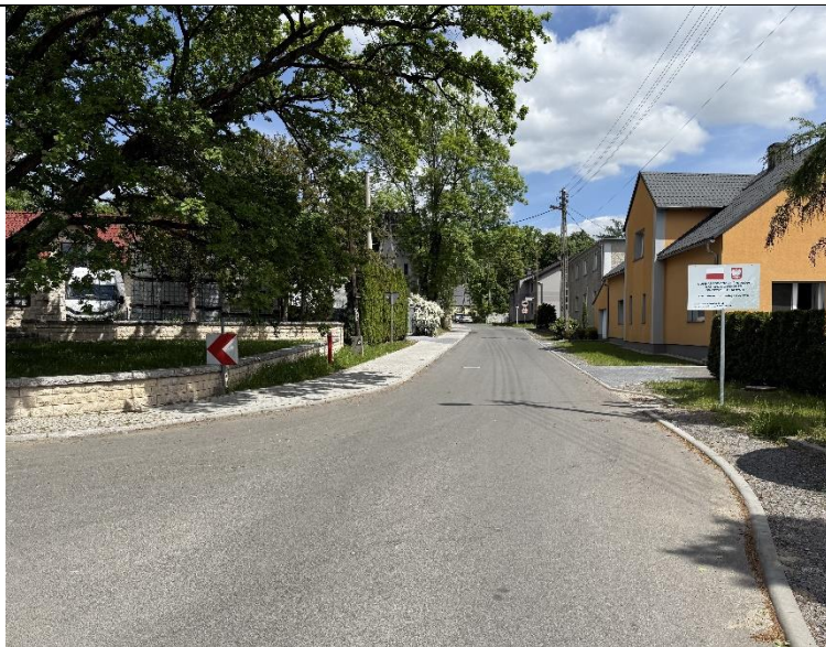
Zdj. 2 Przebudowa ul. Korfantego w Żyrowej.
