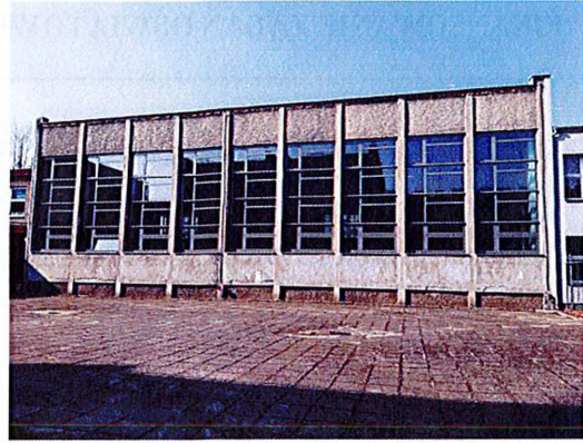
Po częściowej termomodernizacji
