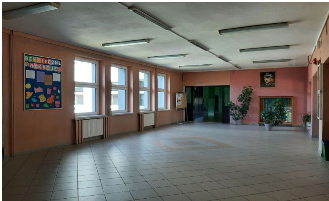
Ilustracja 23: Wykonanie remontu holu w budynku PSP nr 3 w Zdzeszowicach – przed realizacją.
