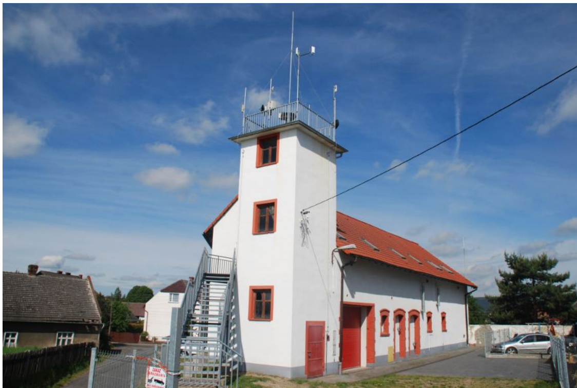
Ilustracja 13: Remont dachu OSP – Żyrowa (FS)
