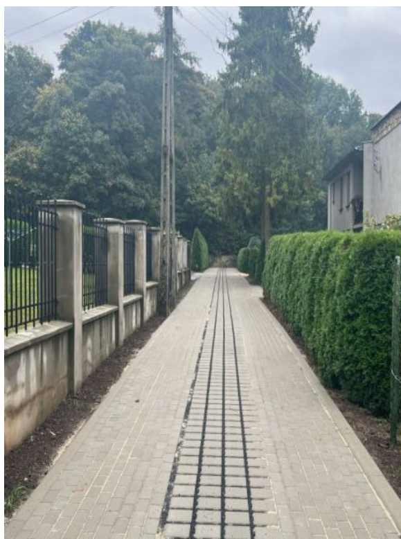
Ilustracja 8: Przebudowa ul. Korfantego
