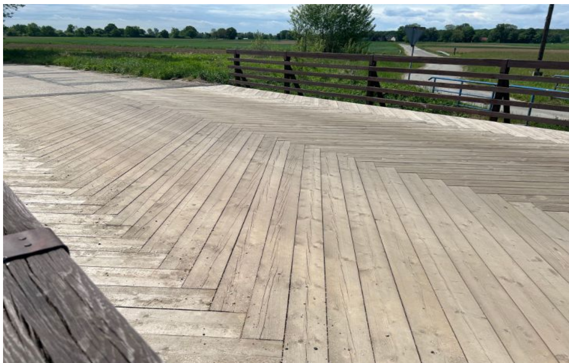
Ilustracja 9: Remont mostku, Januszkowice - ul. Lesiańska
