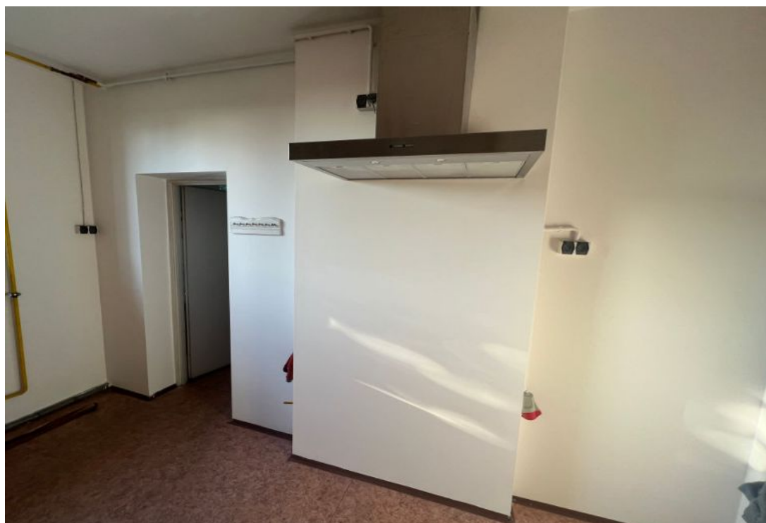
Ilustracja 16: Malowanie pomieszczeń – Januszkowice (FS)
