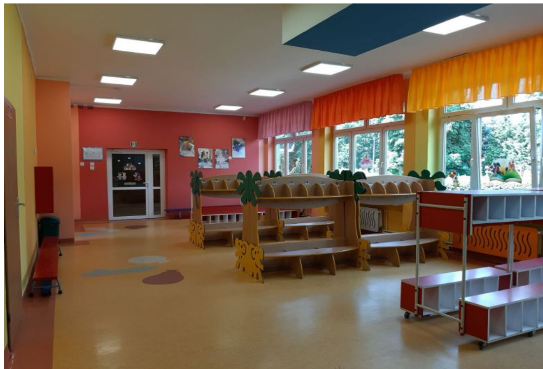
Ilustracja 28: Wykonanie remontu szatni w budynku PP nr 5 w Zdzeszowicach – po realizacji.
