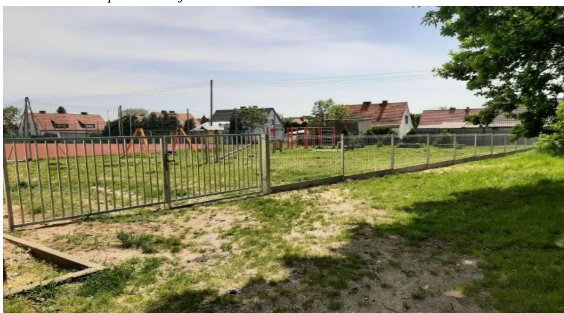
Ilustracja 22: Wykonanie ogrodzenia placu zabaw przy budynku PSP nr 2 w Zdieszowicach – po realizacji.
