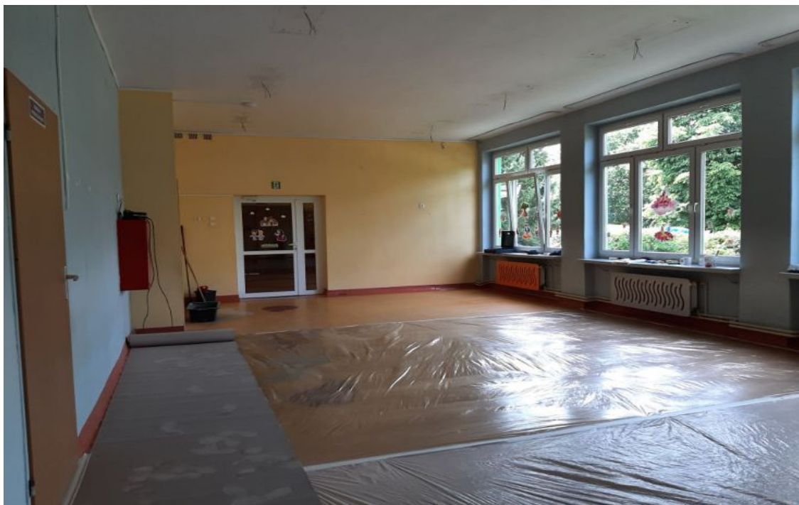
Ilustracja 27: Wykonanie remontu szatni w budynku PP nr 5 w Zdzeszowicach – przed realizacją.
