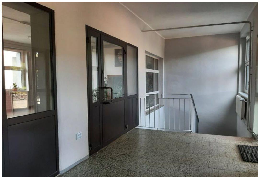
Ilustracja 26: Wykonanie remontu klatki schodowej w budynku PSP nr 3 w Zdzeszowicach – po realizacji
