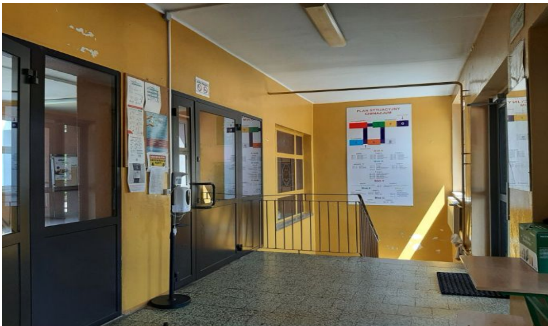
Ilustracja 25: Wykonanie remontu klatki schodowej w budynku PSP nr 3 w Zdzeszowicach – przed realizacją.
